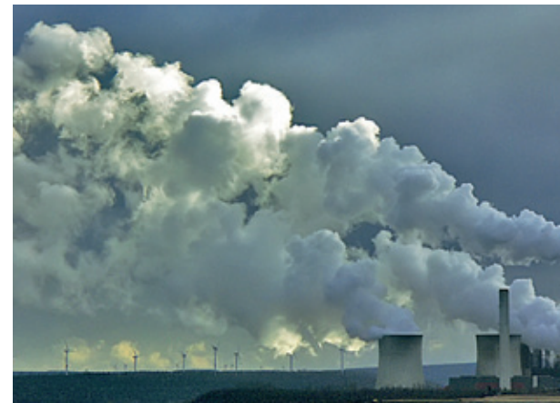
FRISCHER WIND IN DER ENERGIELANDSCHAFT: Die Verbrennung fossiler Energieträger ist das Hauptproblem für unser Klima. Der „Treibstoff“ Wind verbraucht dagegen keine Ressourcen und produziert keine Abfall- oder Reststoffe.
